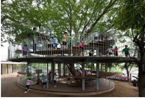
Şekil 7. Fuji Anaokulu Ek Binası Genel Görünümü (Kida 2011)
