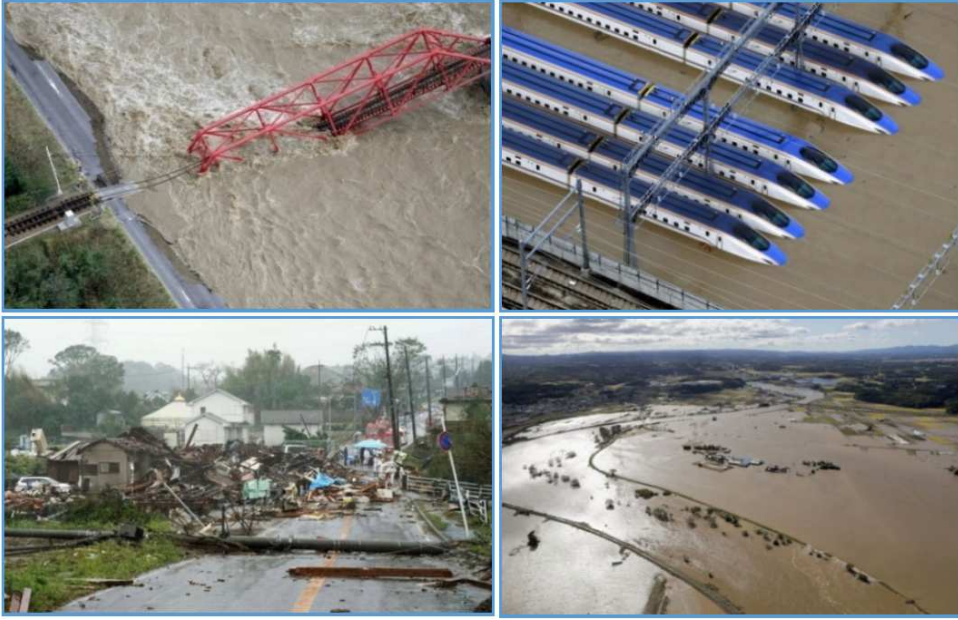
Şekil 8. Hagibis Tayfunu Yıkımları (Taylor, 2019), Demiryolu Köprüsü, Chikuma Nehri, Ueda (sol üstte), Shinkansen Depolama Alanı, Nagoya (sağ üstte), Konut Alanı, Ichibara (Doğu Tokyo) (sol altta), Sel, Tamagawa Kasabası, Fukushima (sağ altta)
