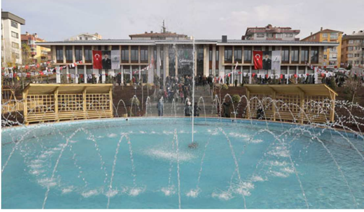
Şekil 4. Yıldız Hizmet Binası ve Belediye Bahçesi
