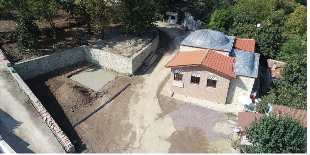
Hat Müzesi ve karşısında yapılmakta olan mescid'in yeri (Beton atılı yer)
