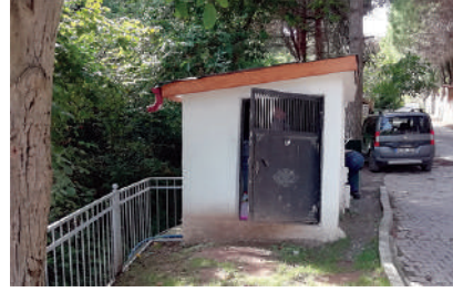
Mesire maballi yanında Türbe'ye su basan pompa kulübesi
