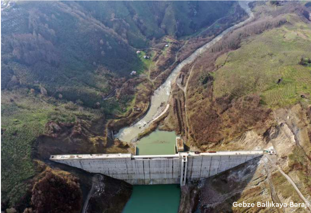
Gebze Kavaldere Barajı
