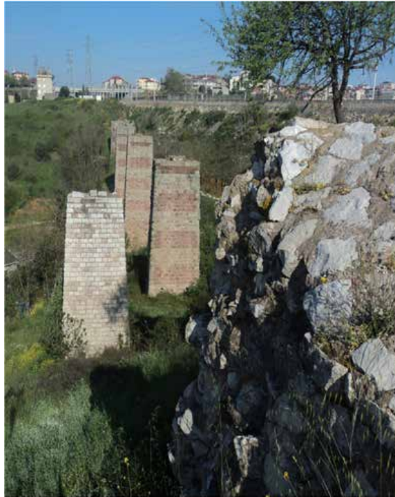
Foto 1. Gebze demiryolu istasyonunun 500 m. kadar doğusundaki Kuruçesme Dere vadisi üzerine 1896 yılında inşa edilen köprünün günümüzdeki ayakları.
