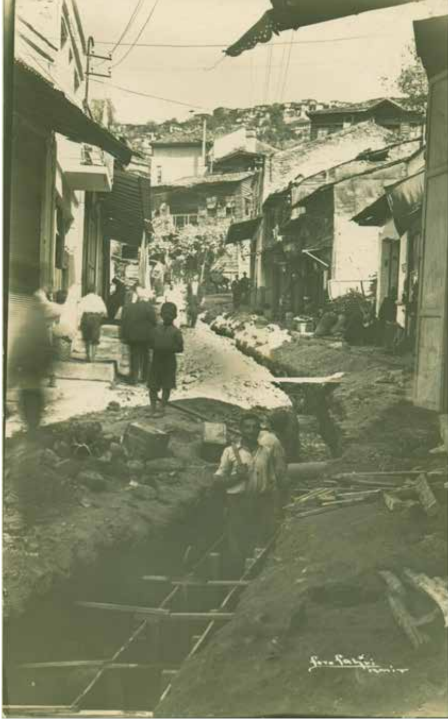
Çarşıbaşı'na kanalizasyon yapımı çalışmaları (1944) (KBB Arşivi)
