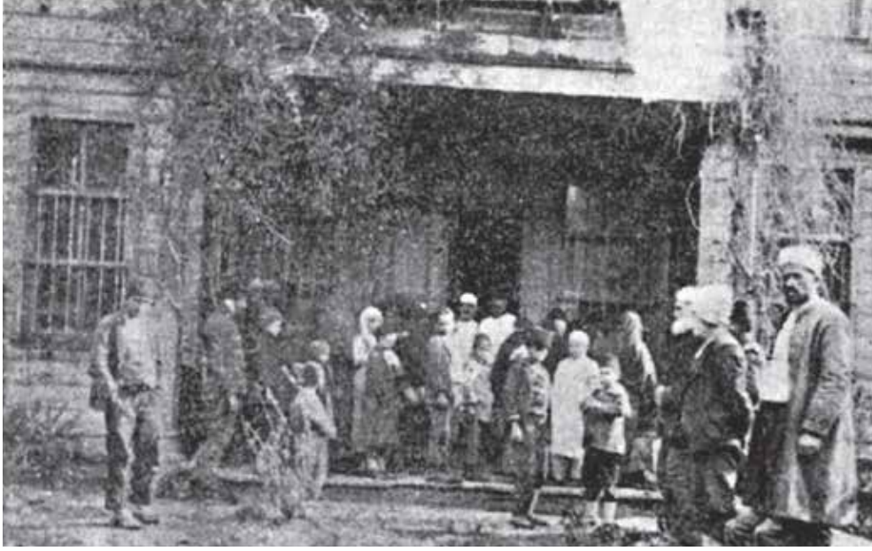
Resim 5: Adapazarı'nda Hilâl-i Ahmer Sekizinci İmdâd-ı Sıhhi Heyeti Binası 58
