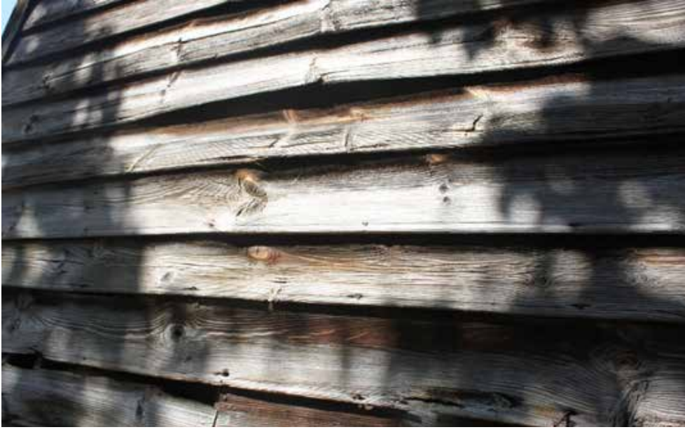
Dış cephede yer kalan ahşap yalıtım baskısı uygulama
