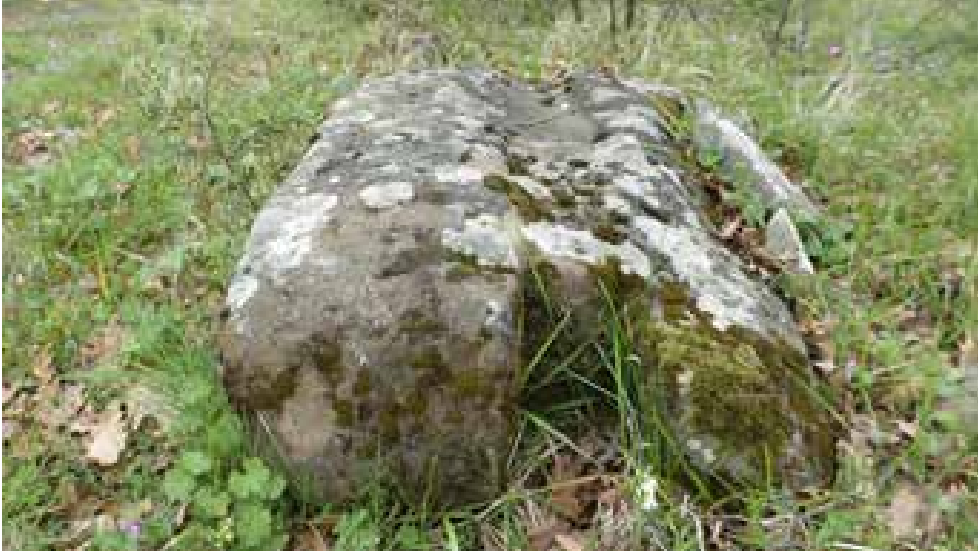
Şekil 29: Ulu Ügümce Köyü Mezarlık Camii'nden günümüze ulaşan temel taşlarında yatay ve düşey ahşap izleri
