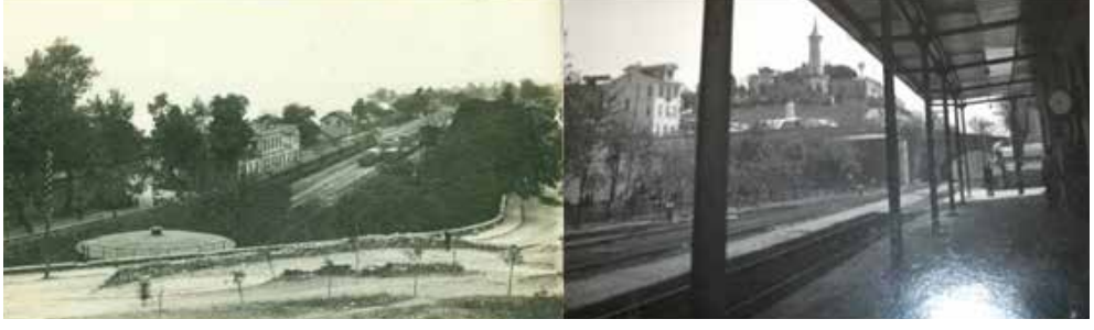
Resim-4: Solda 1930 yılında İzmit tren istasyonu, sağda 1940 yılında istasyonun önüne saçak eklenmiş olduğunu görüyoruz.
