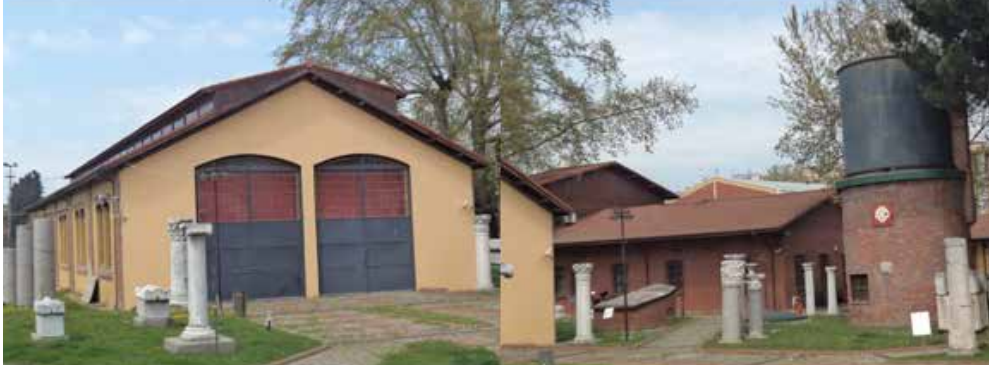
Resim-8: Solda istasyon hangar binası, sağda su deposu ve müştemilatlar. 32
