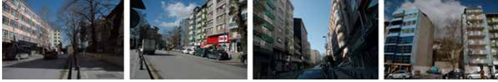
Şekil 5. Kentsel Sit Alanını Güney Yönünde Sınırlayan Yüksek Binaların Bulunduğu İnönü Caddesi (2014)
