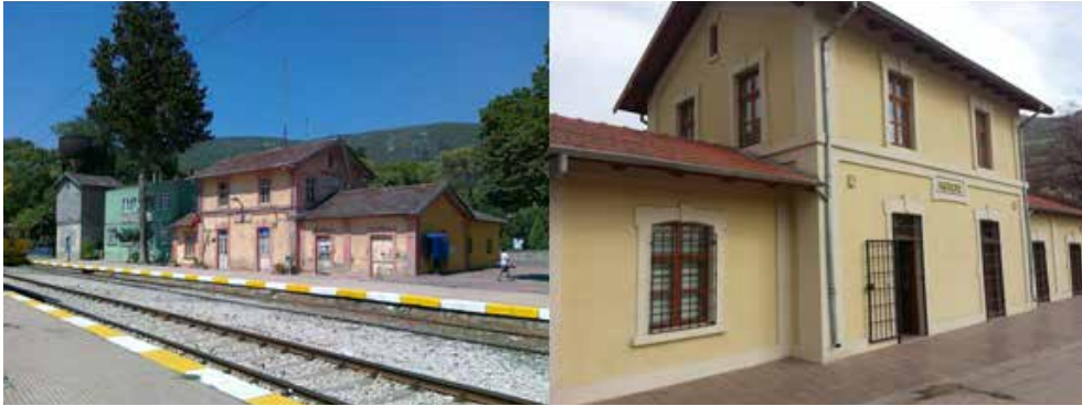
Resim-10: Solda Hereke tren istasyonu restorasyondan önceki durumu ve müştemilatları, sağda Hereke tren istasyonunun restorasyon sonrası durumu görülmektedir. 37,38
