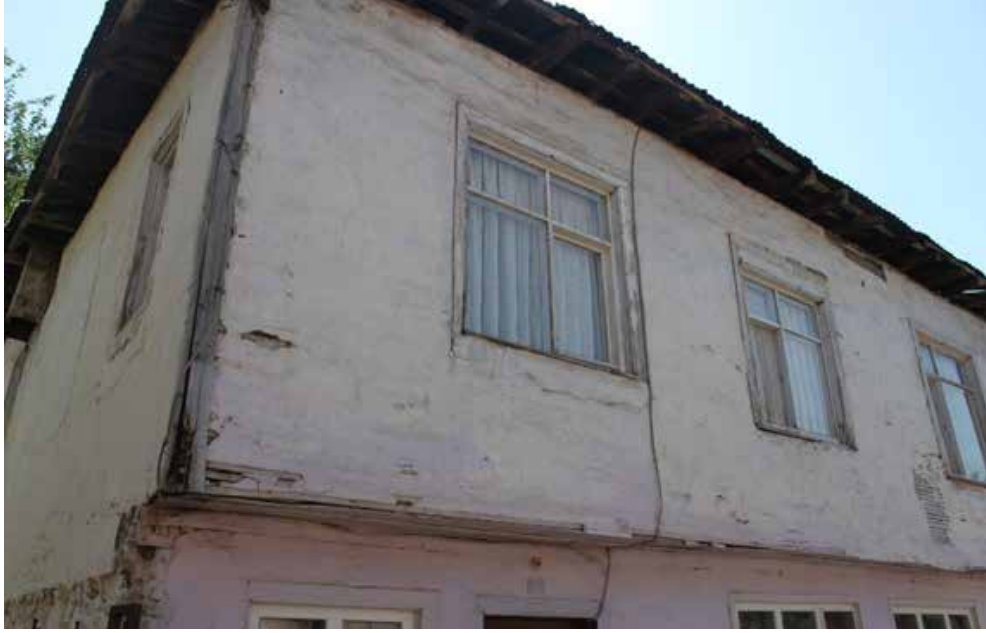
İnönü Cad. No.8'de yer alan konutun yol cephesinden görünüm
