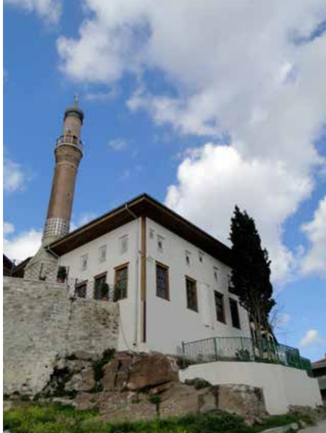
Şekil 3- Akça Koca Camii, onarım sonrası genel görünüş, 2014
