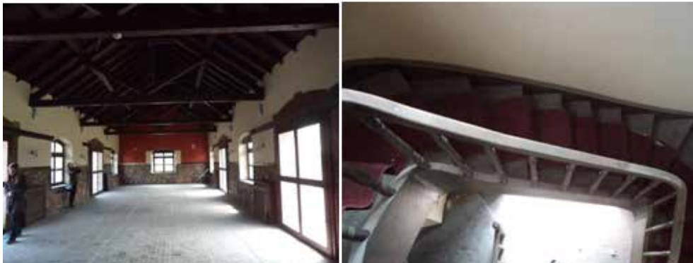
Resim 7: Ambar binası dış ve iç görünüşleri. 31
