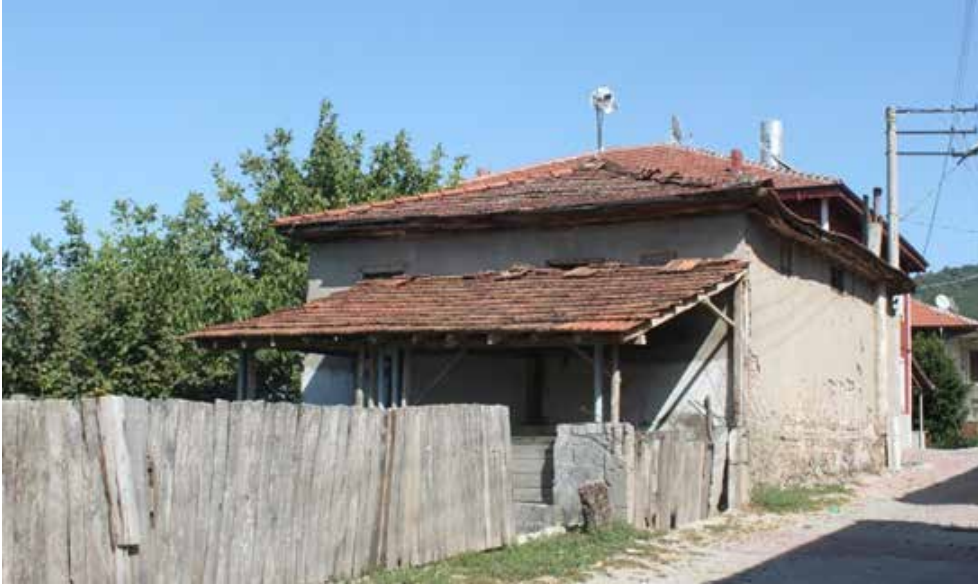
Yavuz Akın Evi'nin yan ve yol cephesinden görünüm
