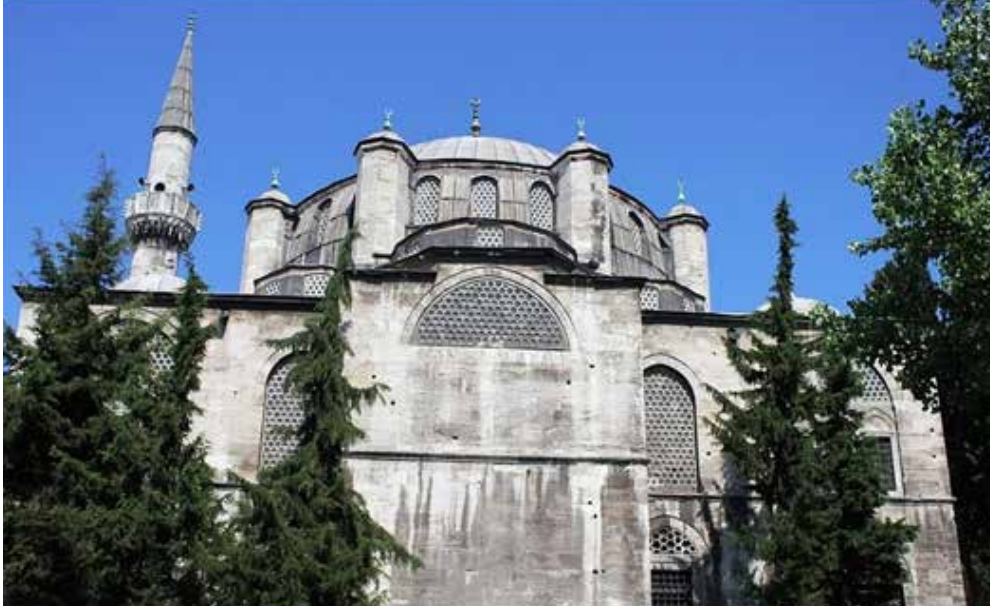
Foto.21:İstanbul Mesih Ali Paşa Camii'nin Alçı Şebekeli Pencereleri
