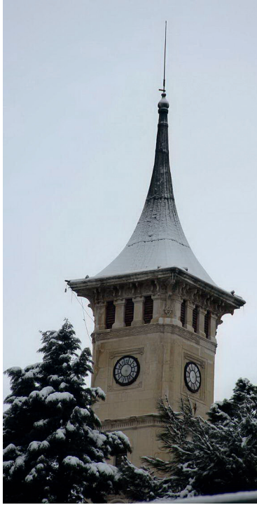
Fot.49, saat kulesinin çatısı ve saçakları
