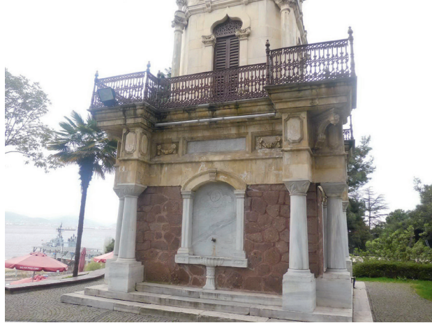
Fot.32, cepheden görünüm
