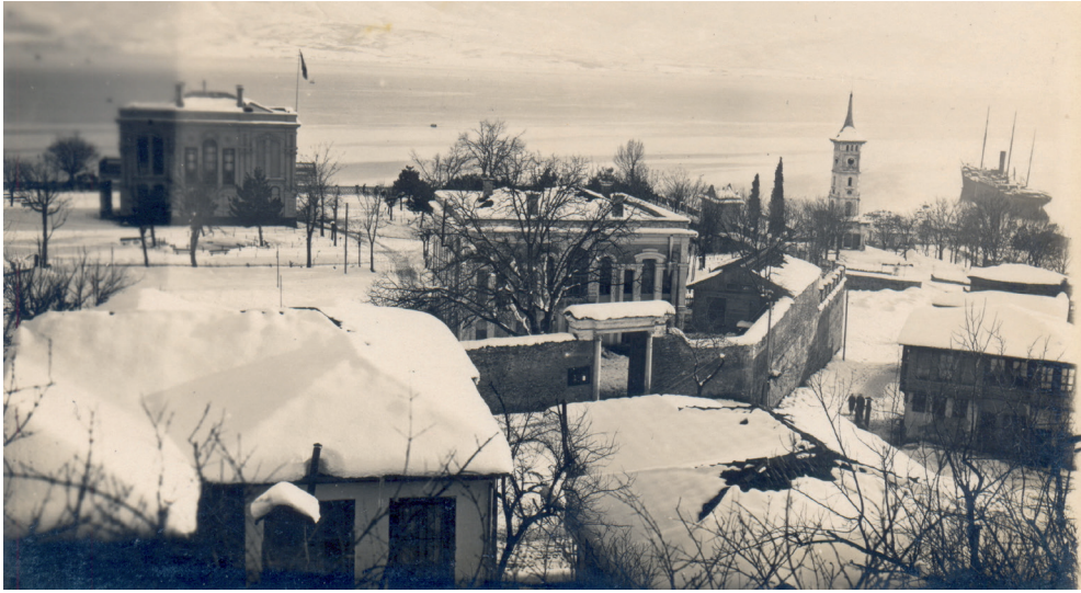
Fot.26, 1926.lar, Kasrı Hümayun ve Saat Kulesi, Kocaeli Belediyesinden
