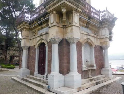
Fot.33, cepheden görünüm
