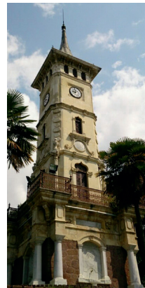
Fot.30, Saat Kulesinden, genel görünüm
