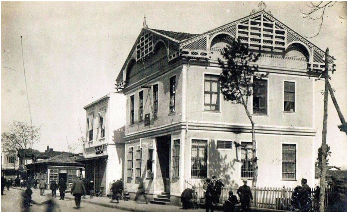
1924 Yılında Adapazarı Posta ve Telgraf Merkezi Binası.
