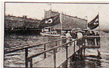
Havuz kızaktan indikten sonra denizde. Montaj çalışmaları yapılırken (Gölcük)
