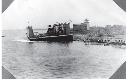
Resim 5 Gölcük'te İnşa Edilen Sac Havuz
