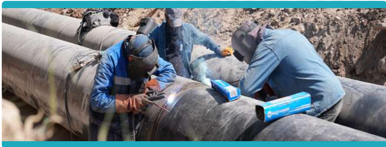
Derince Limandere Bağlantı Yolu Altyapı Çalışmaları
